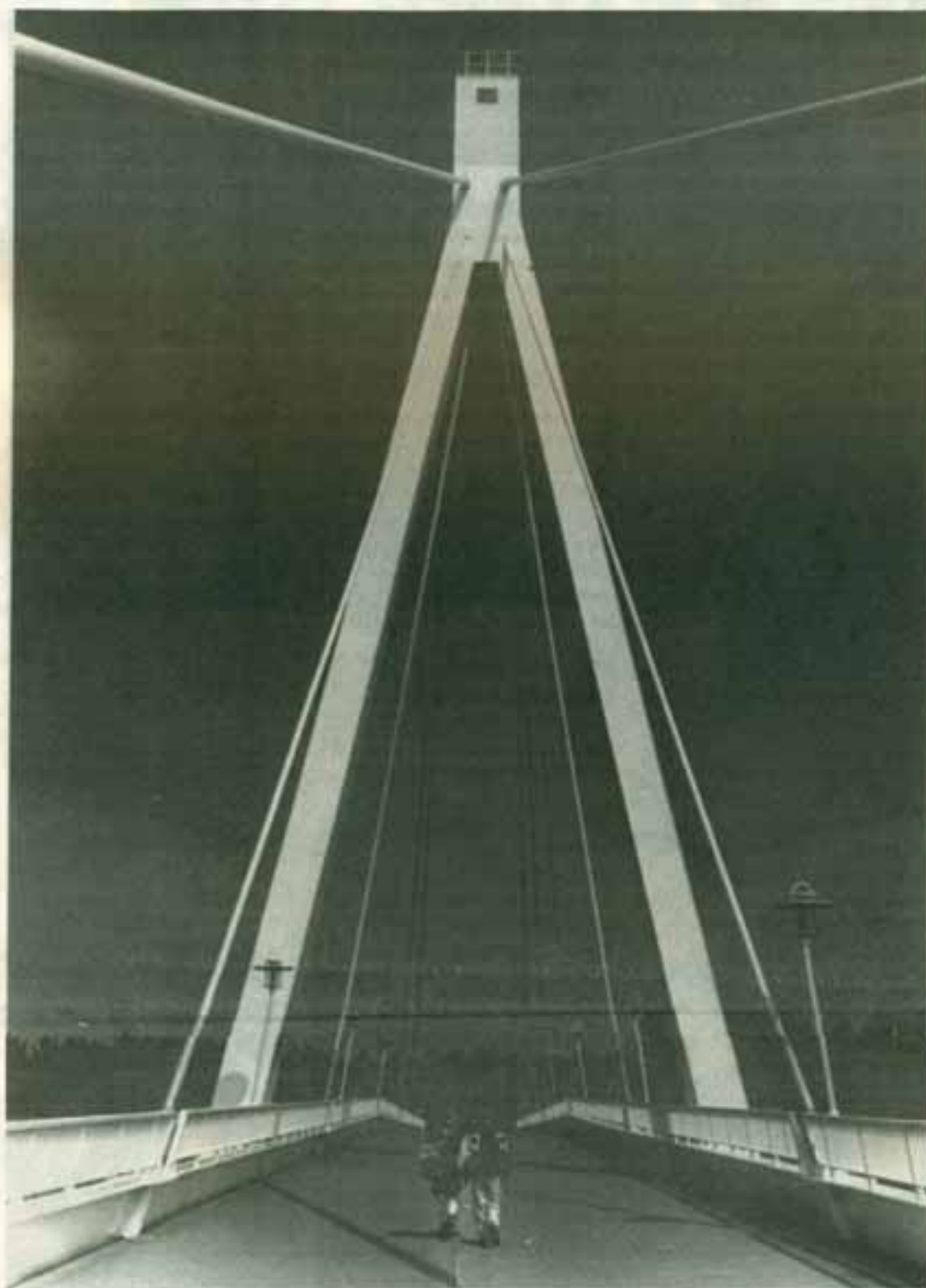
Zevenbergseweg fiets-loopbrug van Rijeroord naar IJsselmonde over de snelweg
