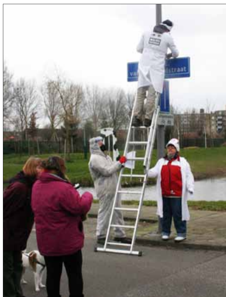
Installatie meetstation Takatukaland
