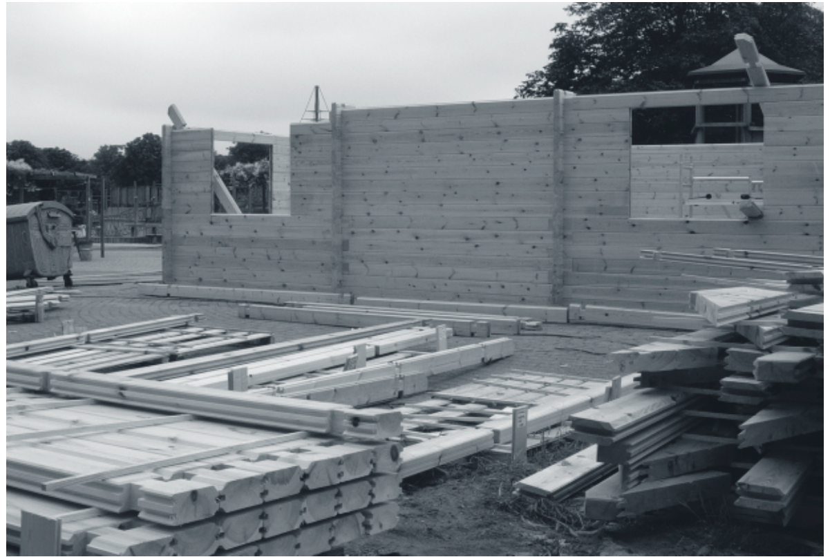
De bouw van de blokhut in Takatukaland is van start gegaan. Foto: dinsdag 12 juni 2007, 13.00 uur.
