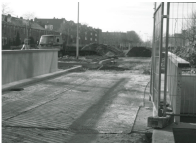
Tijdelijke overgang bij de Tochten in aanbouw Foto: Corstiaan Breedveld.
