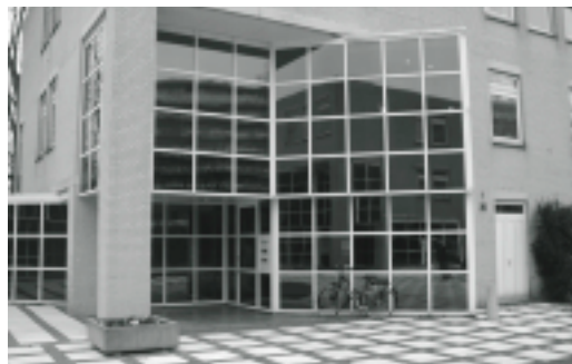
Thomas Mannplaats 301-305. Let op, dit is dus niet in het Goossensflatgebouw maar verderop in de kleinere gebouwen. Foto: Corstiaan Breedveld.
