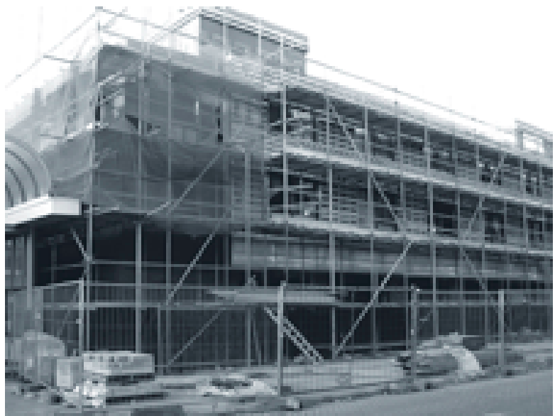
Nieuwbouw Leger des Heils stilgelegd.
